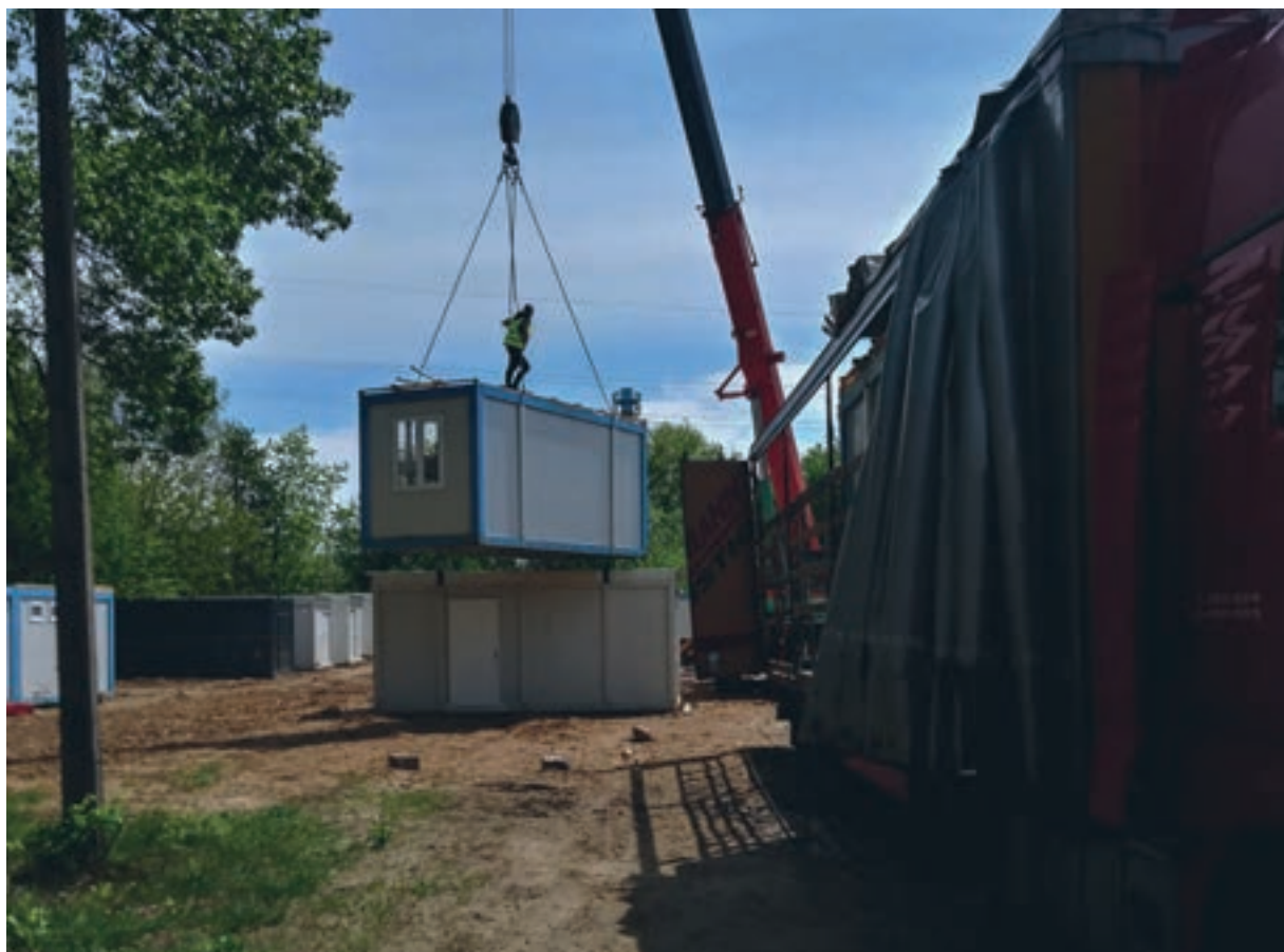
Zdj. Placówka buforowa w trakcie montażu w Warszawie
