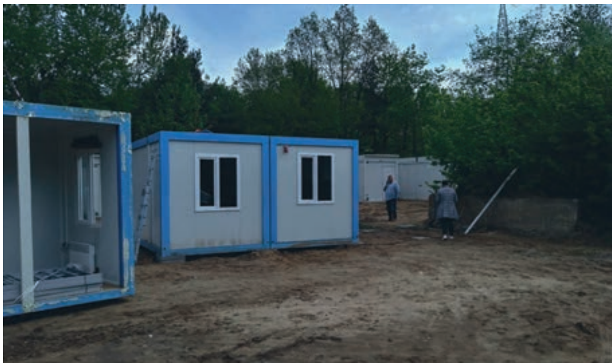
Zdj. Placówka buforowa w trakcie montażu w Warszawie
